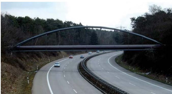
Abb. 5: Oberirdische Fernwärmeleitungen über die B36 in Mannheim
