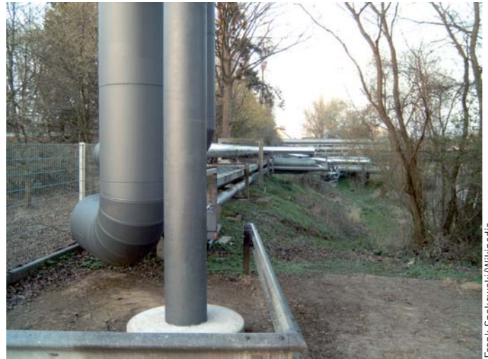
Abb. 4: Oberirdische Fernwärmeleitungen
